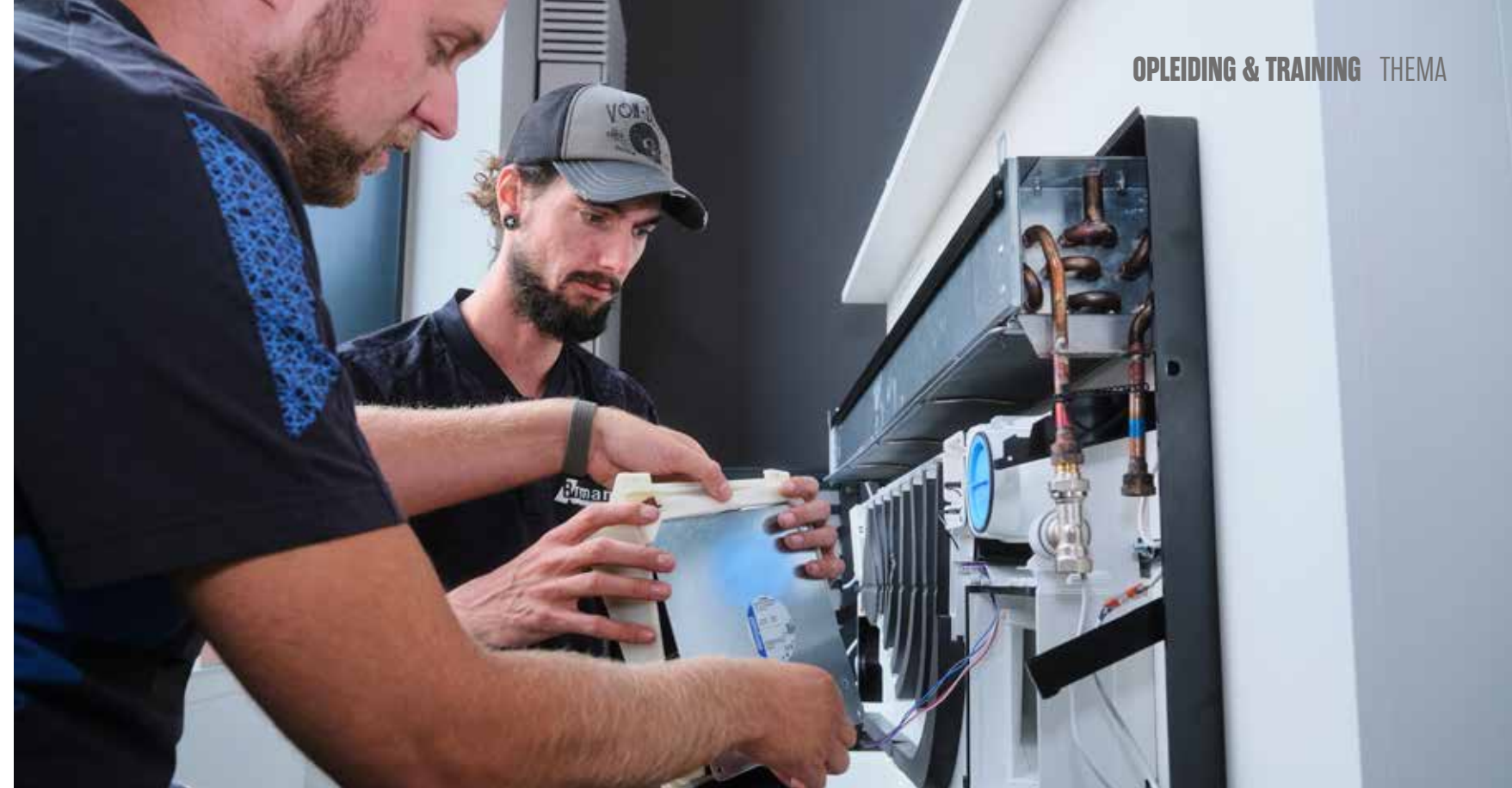
Uitwisselen van componenten aan de ClimaRad Care HTC
