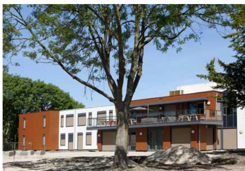
De tuin tussen de 2 gebouwen wordt momenteel aangelegd en zorgt voor een groene verbinding.
