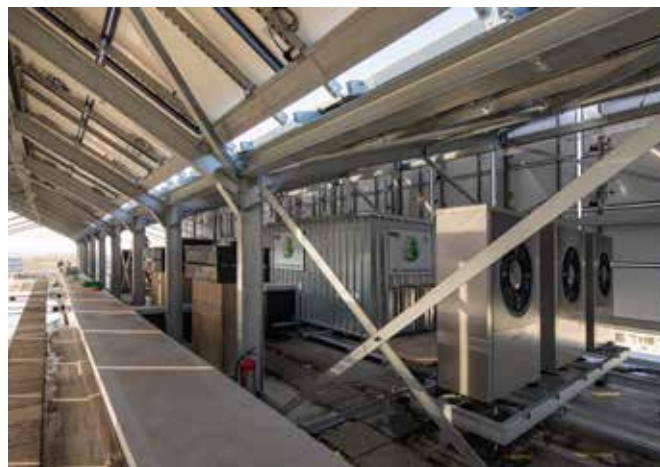
Nu staat er een warmtepomp in de modulaire prefab techniekruimte op het dak, maar die kan eenvoudig worden vervangen door een stadsverwarmingunit of een geothermie-aansluiting.
