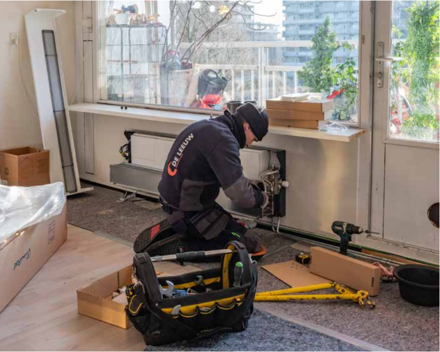
Snelle montage door installatiebedrijf De Leeuw.
