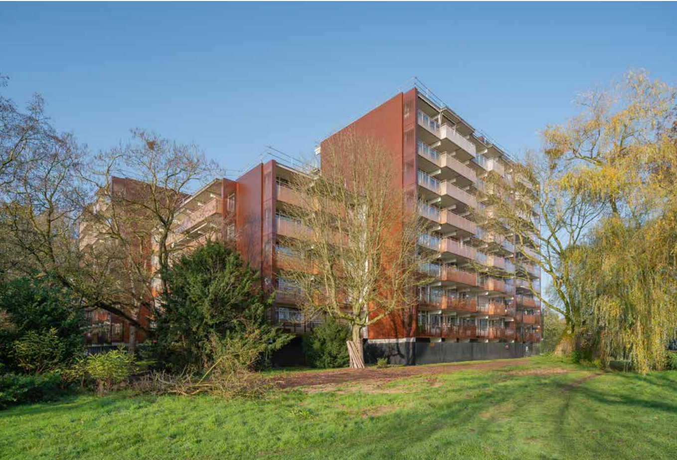
De renovatie omvat 453 appartementen in de wijk Zwanenveld te Nijmegen.
