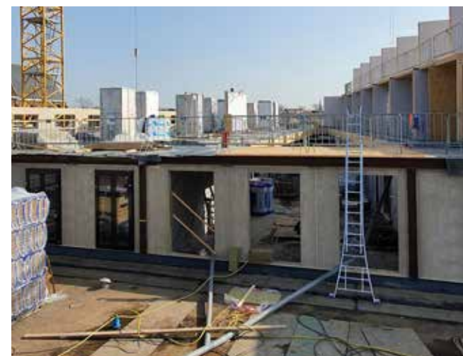
Bovenop het bestaande gebouw komen twee extra verdiepingen.
