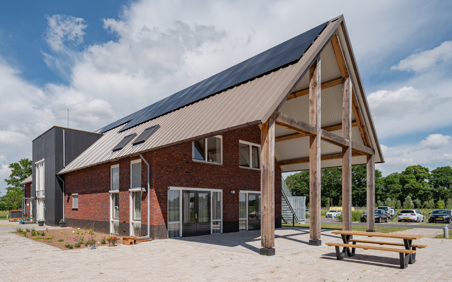
Transformatie monumentale woonboerderij naar zorglocatie.
