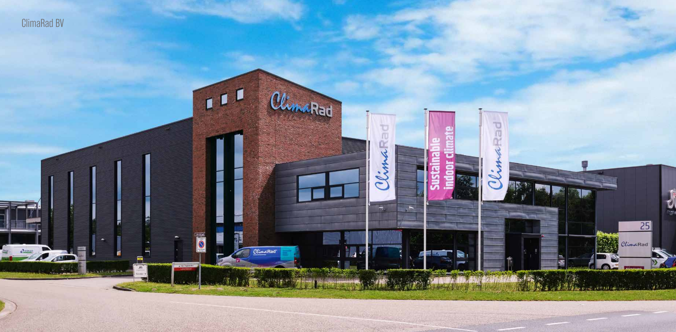
Het pand van ClimaRad BV in Oldenzaal.
