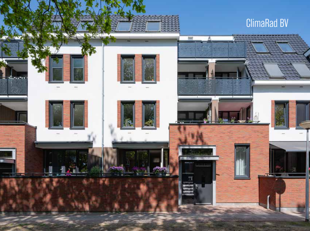
Renovatieproject aan de Kloosterstraat te Oldenzaal.
