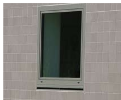
doorvoer onder kozijn **
