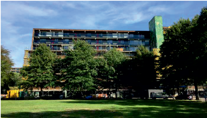
Afbouw van de galerijzijde van flat A, aan de Hertmebrink in Enschede.
